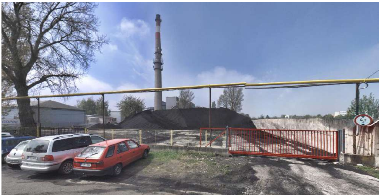
Obrázek 8: ENERGIE Holding a.s. - výtopna Kocanda
